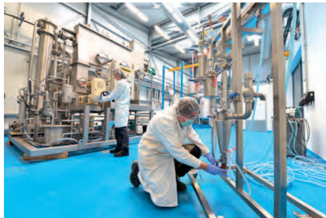
Vue d'ensemble de la salle Atex.
